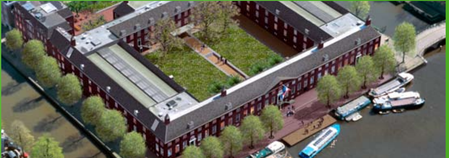
Overzicht De Hermitage, Amsterdam
